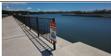
④ 名籠漁港。 看板は設置されているが、 岸壁に出られる。
