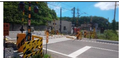
⑥ 陸前富山駅踏切。 遮断機あり。
