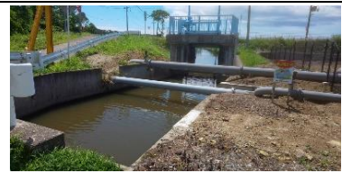
③ 手樽駅近くの水路。 柵などが無い。
