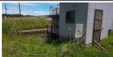
⑦ 名籠(梅ヶ沢)排水機関場 ロープのみで容易に出入り できる状況。
