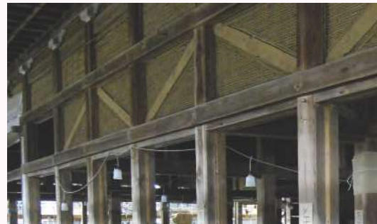
平成の大修理で使用されていることが判明した「筋違」
